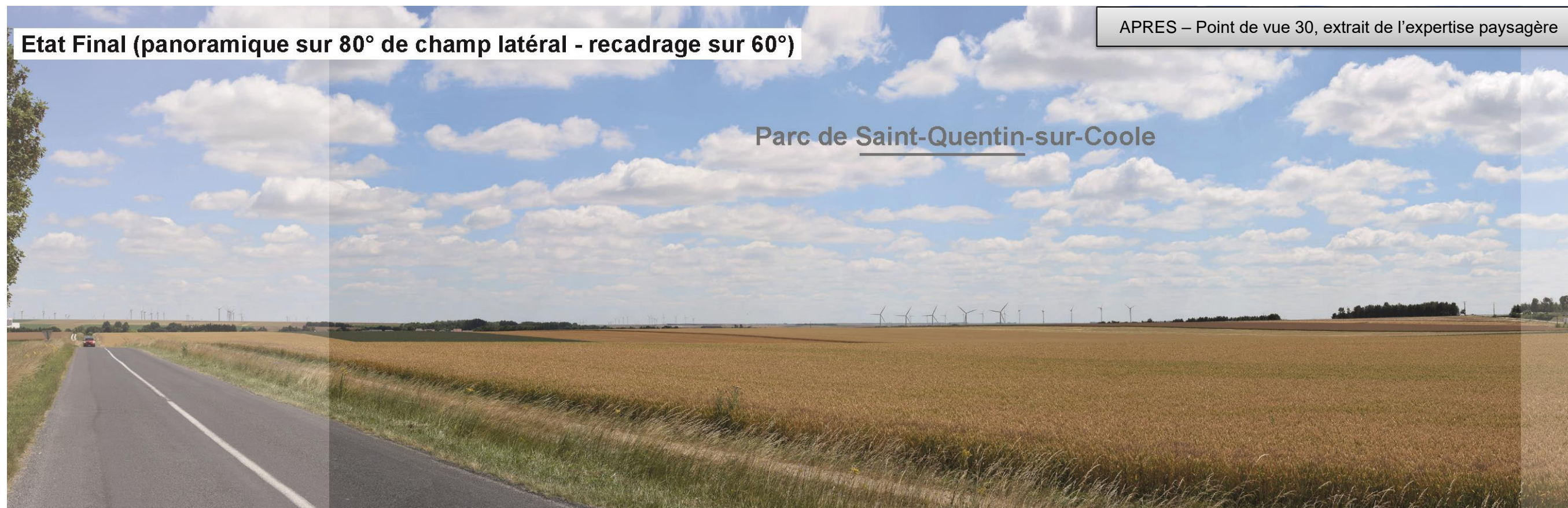
Figure 10 : Point de vue 30 depuis la RD203 à l'Ouest de Nuisement-sur-Coole (source : ATER Environnement, 2019)
